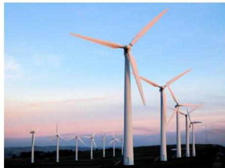
Fig: wind turbine
